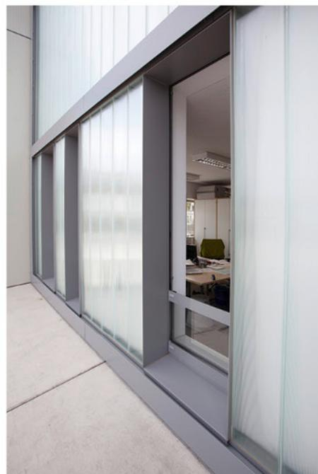
Für einen optimierten Wärmeschutz wurde in die Profilglasfassade eine sogenannte transluzente Wärmedämmung (TWD) eingebracht.
