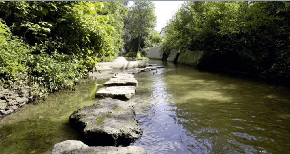
Bei Bauprojekten (im Bild: innerstädtischer Ausbau des Ratzengrabens in Biberach) ist strukturiertes Arbeiten mittels geeigneter Software von Vorteil. Die Wasser-Müller Ingenieurbüro GmbH setzt hierzu auf die ganzheitliche Lösung California.pro. | Foto: Erwin Holzschuh, Neu-Ulm
