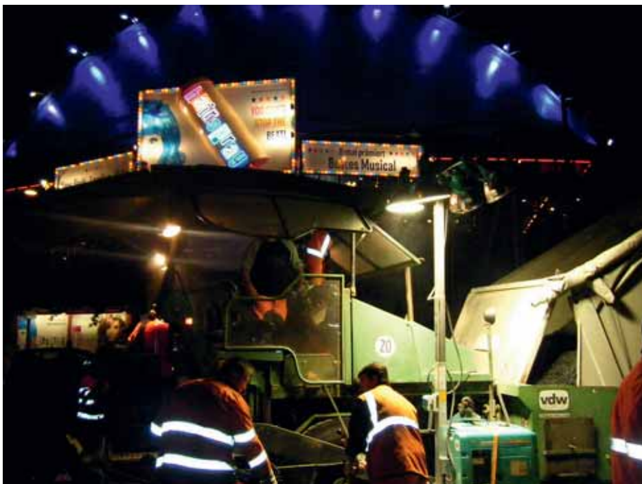
Bindereinbau auf dem Konrad-Adenauer-Ufer bei Nacht vor dem Kölner Musical Dome.
