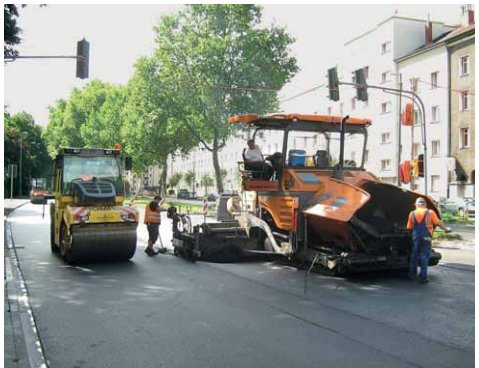
Einbau der Deckschicht auf der Boltensternestraße unter einseitiger Vollsperrung einer Richtungsfahrbahn.
