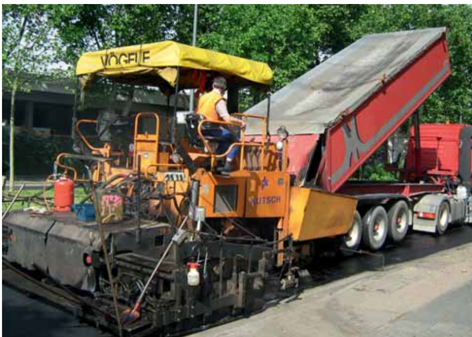
Temperaturabgesenkter Einbau der Deckschicht des gummimodifizierten Asphalttes auf der Boltensernstraße.
