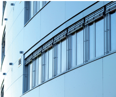
Abb. 3: Büro- und Laborgebäude der Contitemic in Markdorf. Für die Versorgung der einzelnen Arbeitsplätze entwickelte das Ingenieurbüro Sulzer ein flexibles System. Darüber hinaus plante Sulzer die kompletten Elektroinstallationen inklusive EDV-Netz, Sicherheitstechnik sowie Beleuchtungs- und Medientechnik.
