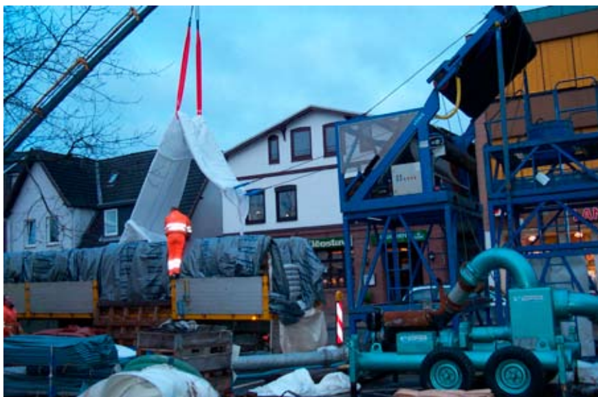
Renovierung eines Regenwasserkanals in der Stadt Bad Bramstedt
