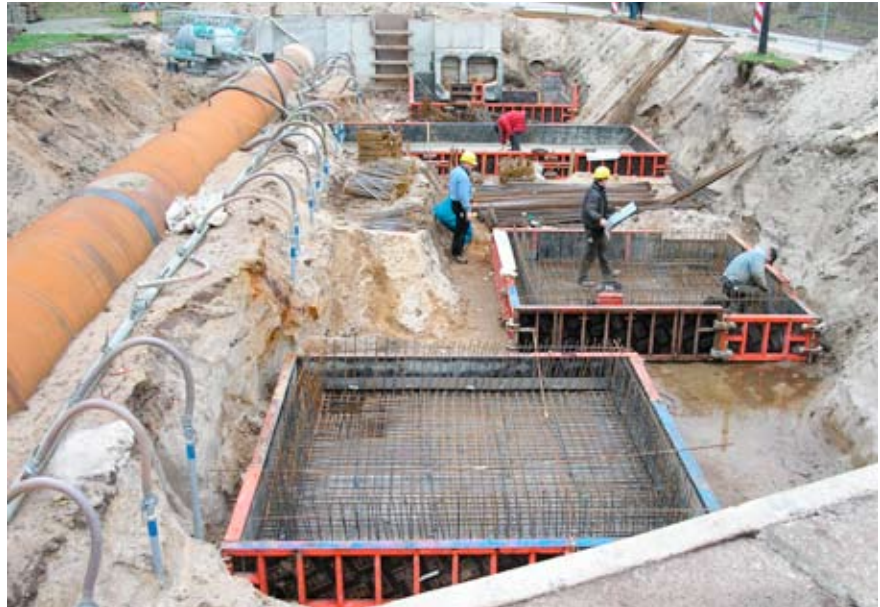
Umbau Hauptvorflutkanal zur Kläranlage der Stadt Neumünster Fotos: Wasser- und Verkehrs-Kontor GmbH
