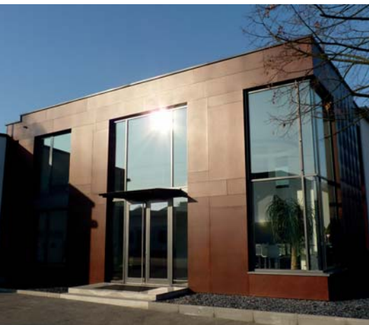
Platten aus afrikanischem Okumé-Schäl furnier bilden die Fassade des Erweiterungsbaus bei Schorn und Groh.
