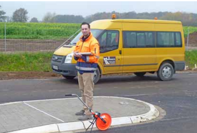
Tobias Farin beim Aufmaß auf der Baustelle
