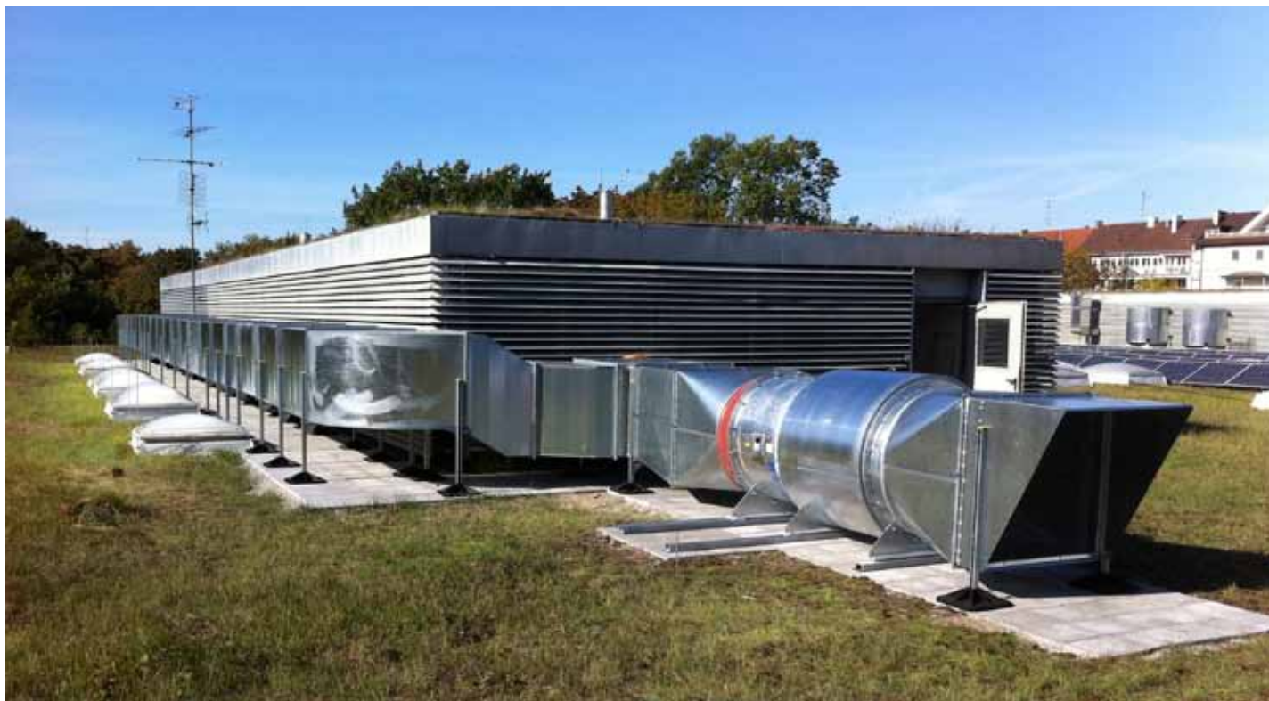
Foto: Haydn Energie Team GmbH, Passau
