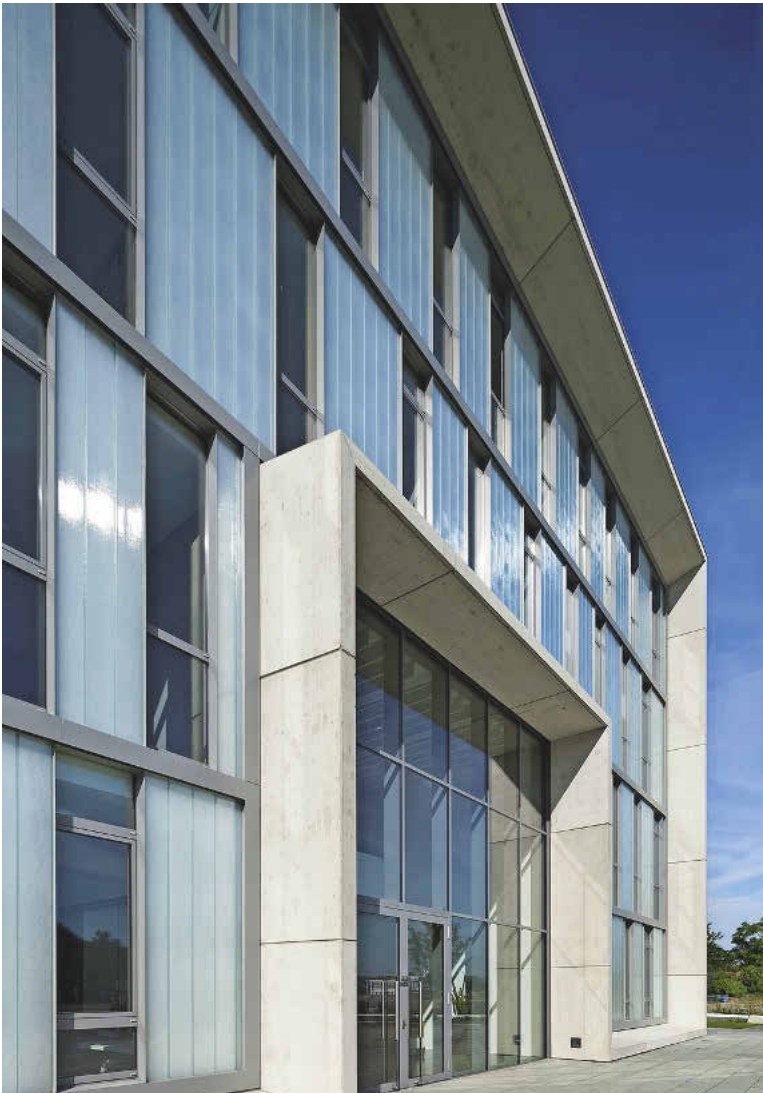
Nordfassade mit umlaufendem Betonkragen.
