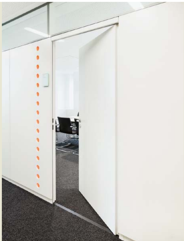
Unübersehbares Besetztzeichen. Um eine Belegung der Besprechungsräume anzuzeigen, können die runden Öffnungen neben den Türen im Sparkassenrot hinterleuchtet werden.
