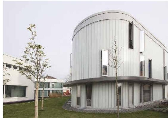
Mit der transluzenten Dämmeinlage in der Profilglasfassade wurden Wärmeschutz, Tageslichtnutzung und Sonnenschutz in einem realisiert.
