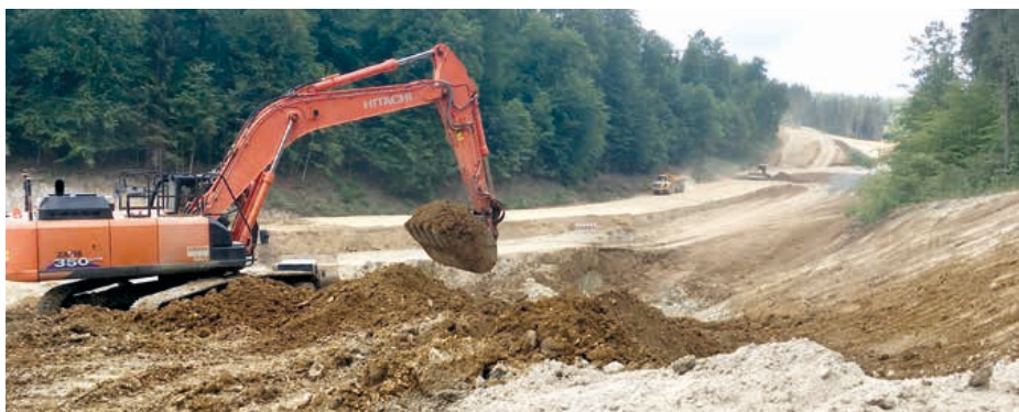
Große Erdbau-Baustelle: In Immendingen entsteht derzeit das Daimler Prüf- und Technologiezentrum.
