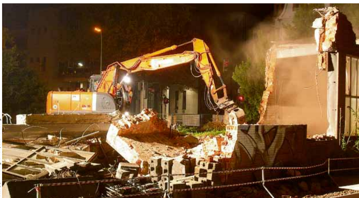
Abbrucharbeiten in Friedberg.
