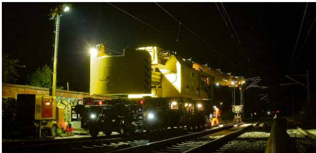
Weichenerneuerung in Leverkusen.
