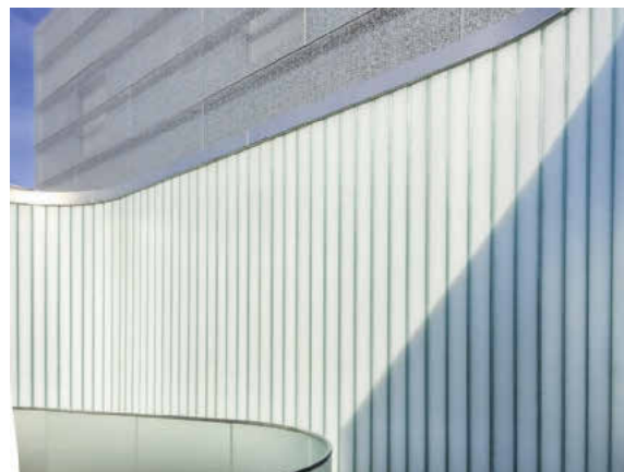
Lichtstreuend und lichtdurchlässig: TWD verteilt das Licht schlagschattenfrei und bietet Schutz vor sommerlicher Überhitzung.
