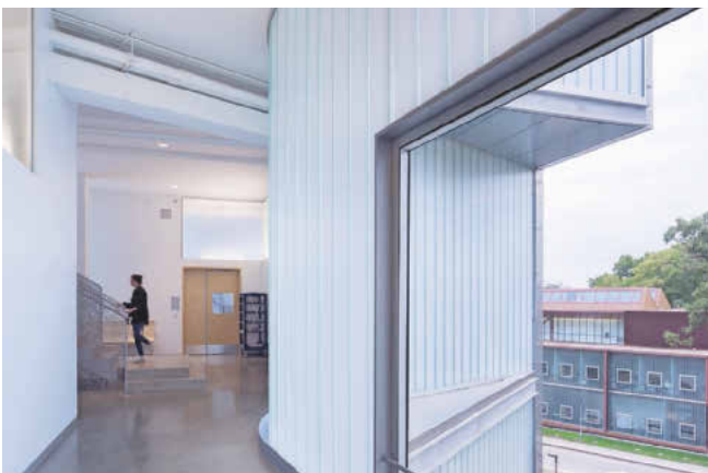
Damit diffuses Licht ins Innere des Gebäudes gelangt bei gleichzeitigem Wärme- und Sonnenschutz, setzten die Architekten auf transluzente Wärmedämmung.
