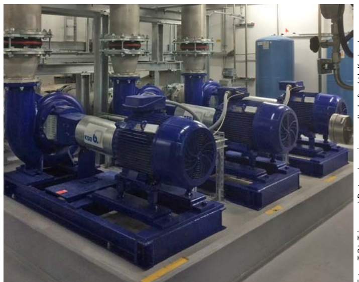
Fotos: T.P.I. Trippe und Partner Ingenieurgesellschaft mbH, Karlsruhe
