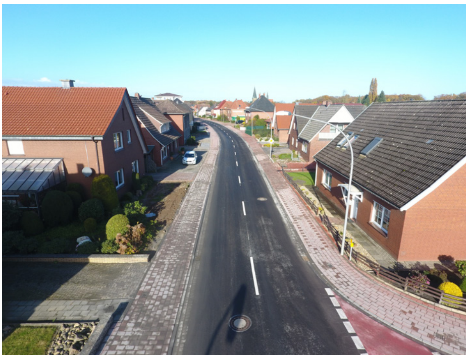
Bild der Befliegung des Bauvorhabens Straßen- und Kanalsanierung der Stadt Bersenbrück
