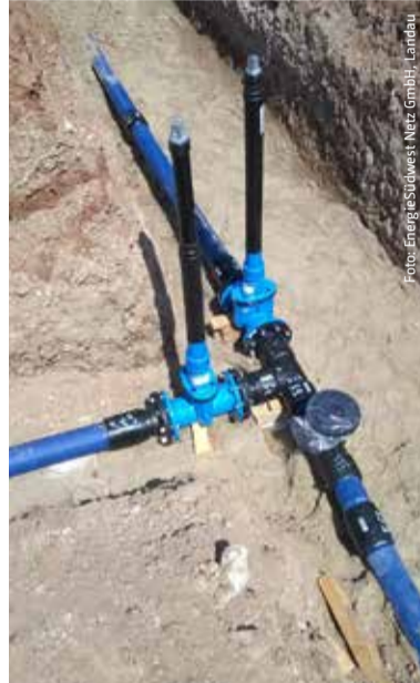
Erneuerung Schieberkreuz - Wasser
