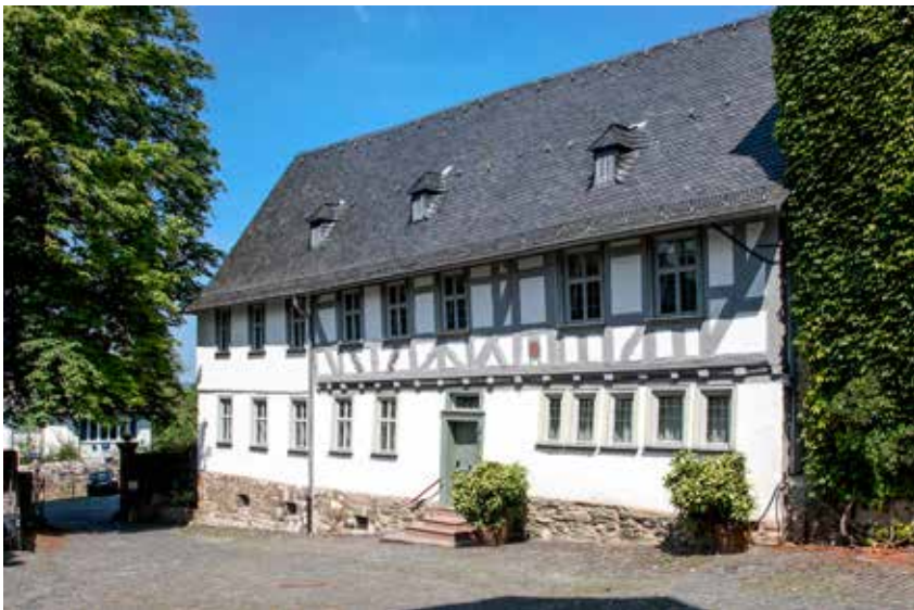
Denkmalgerechte Sanierung einer Goethe-Gedenkstätte in Wetzlar
