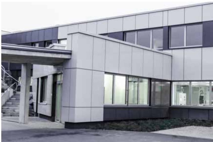
Neubau Radiopharmazie an der Zentralklinik Bad Berka
