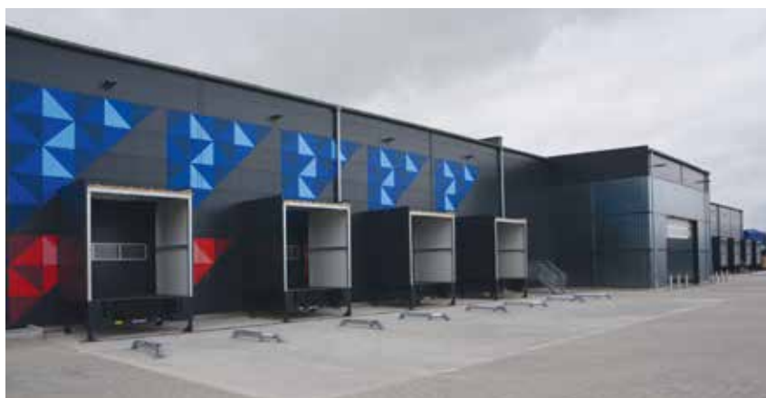
Lagerhalle für Gefahrstoffe für Glomm Logistics
