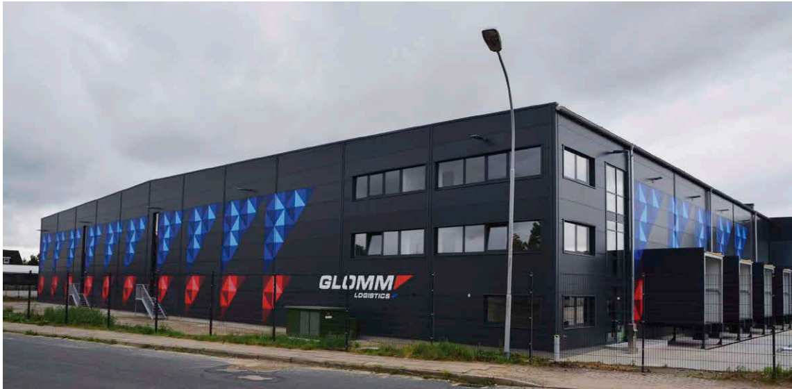
Abb. 1: Lagerhalle für Gefahrstoffe für Glomm Logistics.
