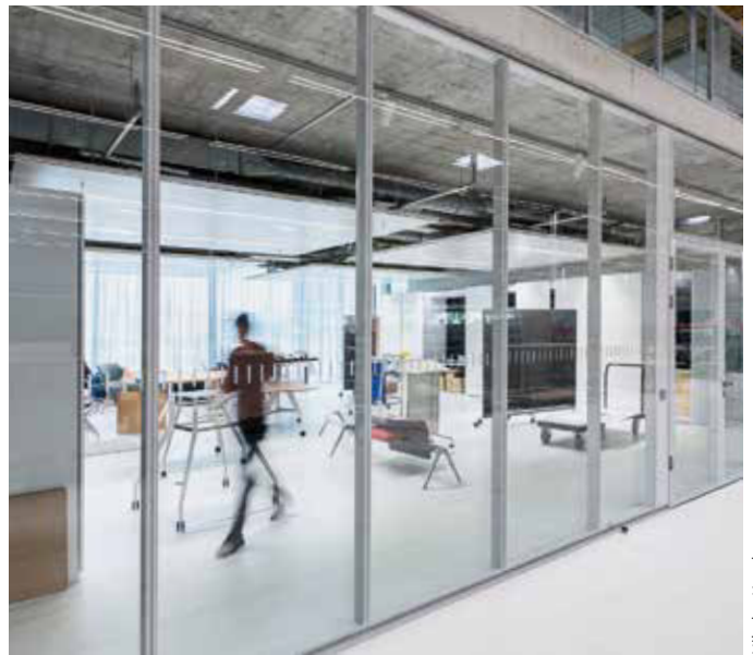
Die hochschalldämmende Structural-Glazing-Verglasung fecostruct mit 105 mm Wanddicke ermöglicht es, Büros direkt neben der Produktion anzuordnen.
