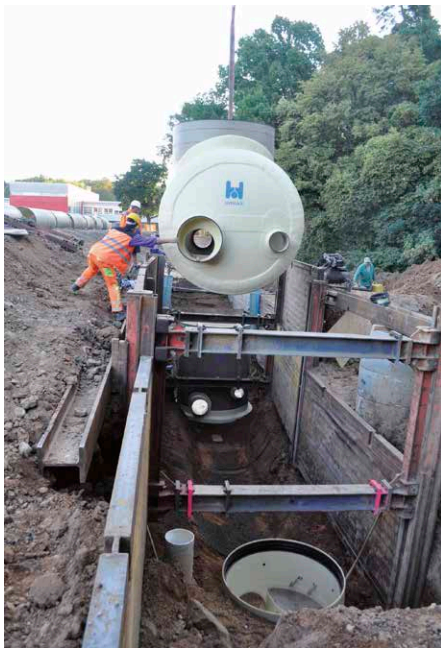
Abb. 2: Versetzen des Drosselbauwerkes.
