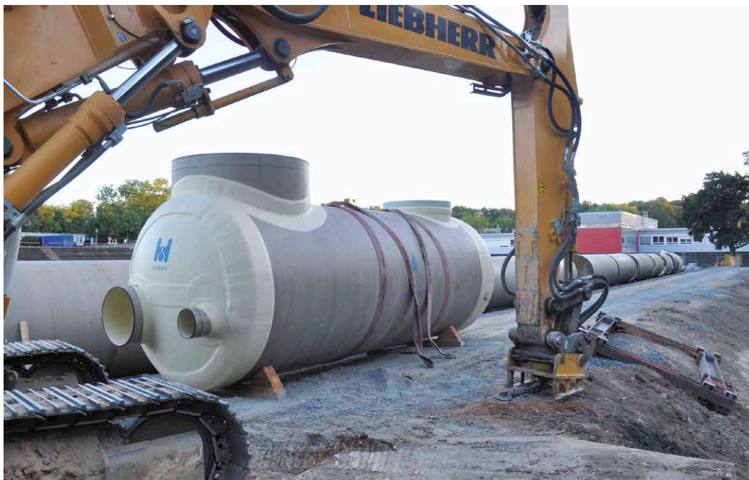
Abb. 1: Anlieferung des Drosselbauwerkes GFK Rohr DN 2400.
