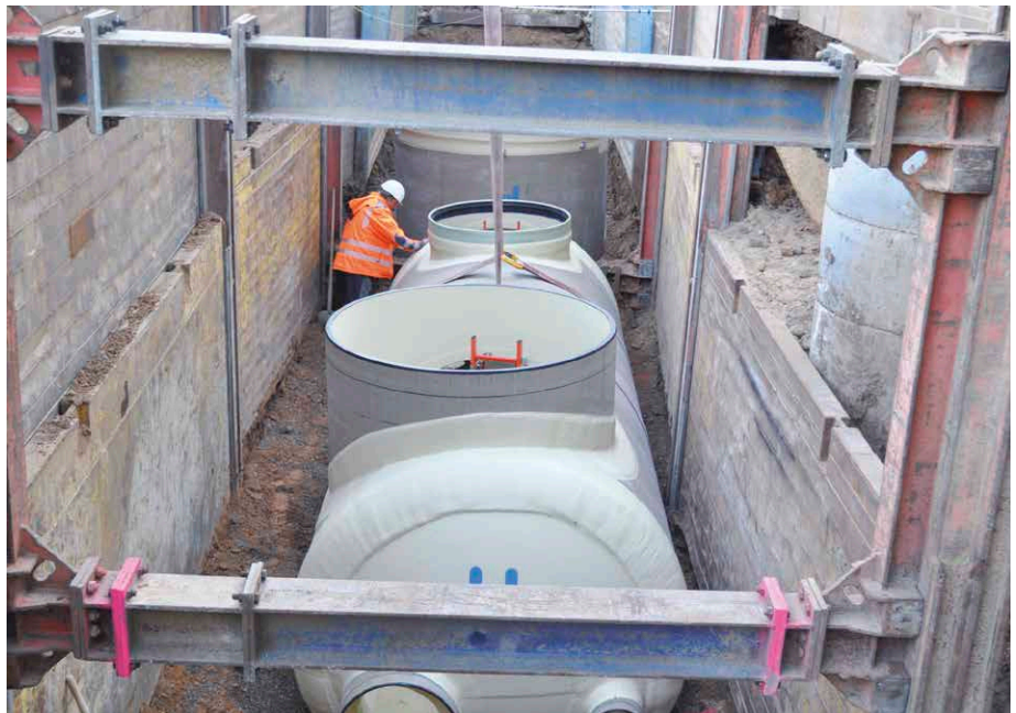
Abb. 3: Eingebautes Drosselbauwerk.
