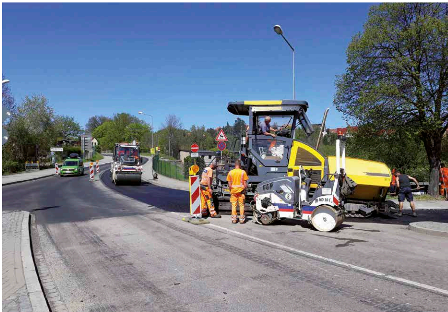
Abb. 2: Freital, Deckenerneuerung S 36.
