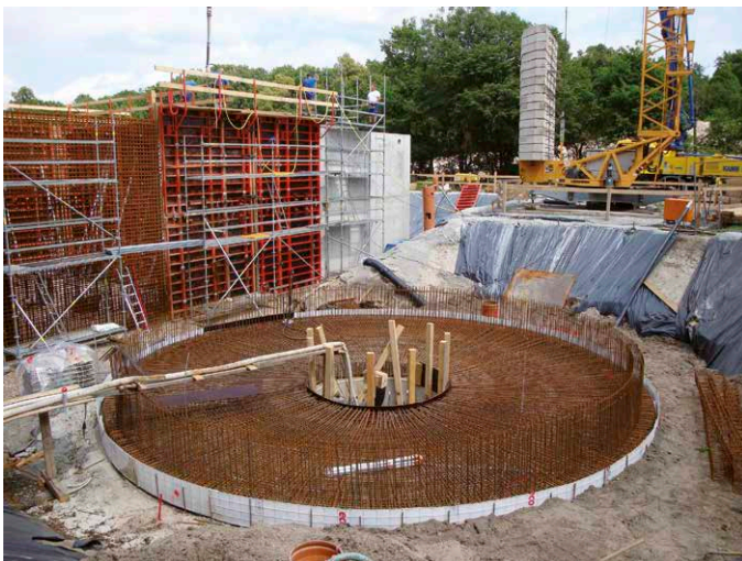
Abb. 3: Kläranlage Schwepnitz, Stahlbetonarbeiten am Nachklärbecken.
