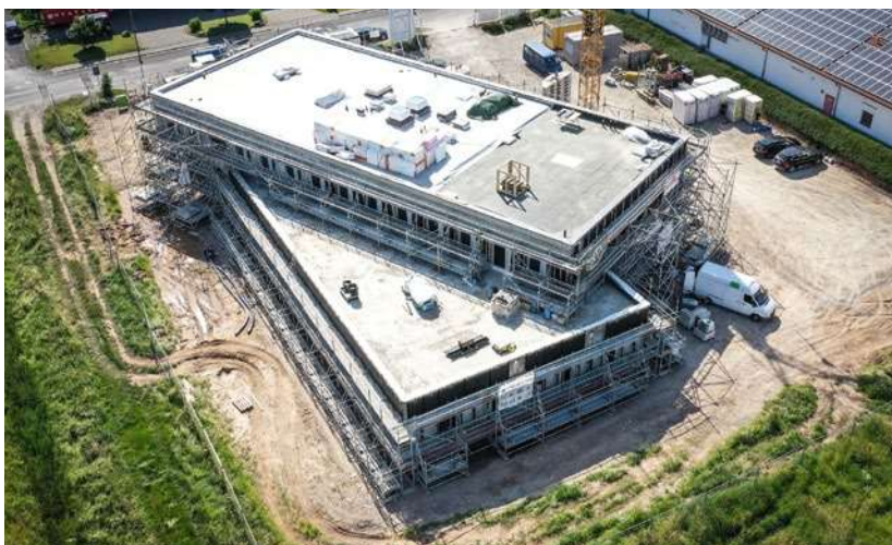
Richtfest des Dienstleistungszentrums der Kreissparkasse Gelnhausen.
