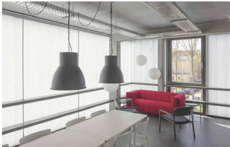
Die Profilglasfassade belichtet die zur Straße liegenden Gemeinschaftsräume.
