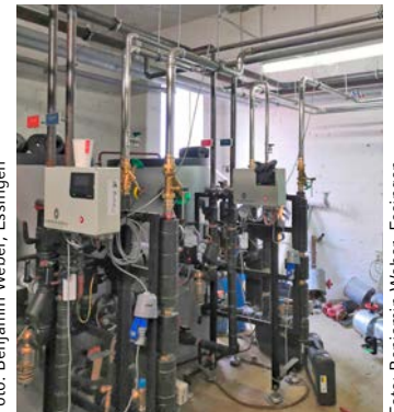
Sanierung der Warmwasserbereitung in einem Mehrfamilienhaus in Ludwigshafen
