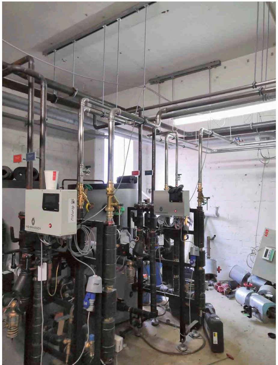
Abb. 1: Sanierung der Warmwasserbereitung in einem Mehrfamilienhaus in Ludwigshafen.
