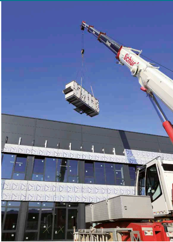
Abb. 2: Neubau Logistikhalle mit Büroeinbau, Antieferung Lüftungsgerät.
