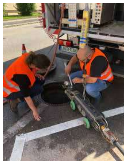
Kontrolle des Fräsroboters im Zuge der Bauüberwachung
