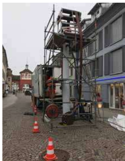
Inversionsturm zur Sanierung mit Schlauchlining im Warmwasser-Härteverfahren
