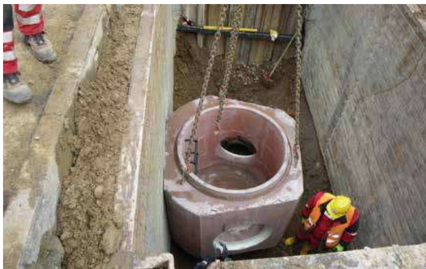
Einbau eines neuen Abwasserkontrollschachts in die bestehende Kanaltrasse als Vorsanierung
