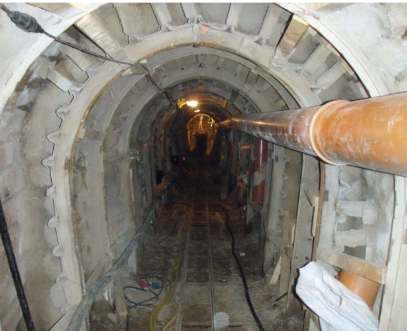
Abb. 1: Spezialtiefbau im Stollen in Köln.
