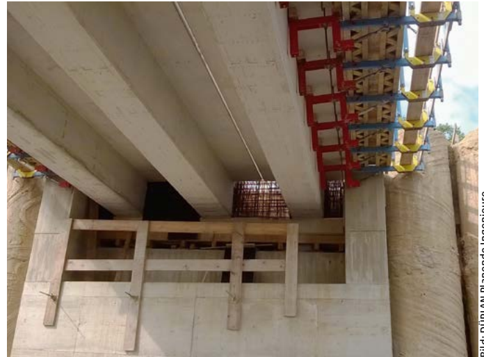
Abb. 4: Brückenbauwerk der Ortsumgehung Frechen Buschbell.
