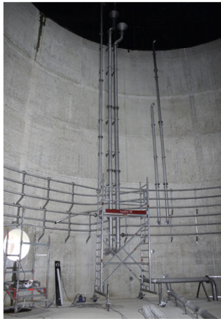
Innenansicht Faulbehälter bei der Montage der maschinellen Ausrüstung
