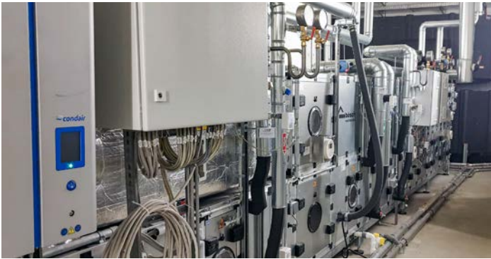
Erneuerung Lüftungsgeräte und Umbau Wärmerückgewinnung im MDR-Landesfunkhaus Sachsen-Anhalt in Magdeburg
