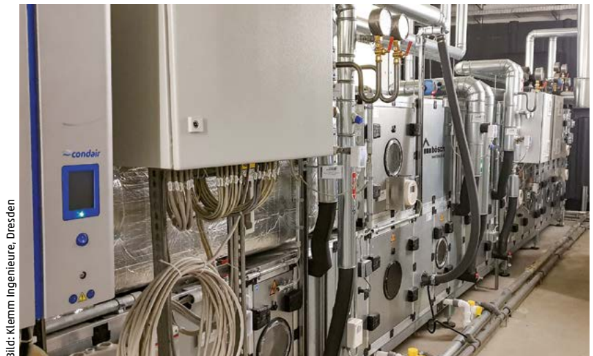
Abb. 2: Erneuerung der Lüftungsgeräte und Umbau der Wärmerückgewinnung im MDR-Landesfunkhaus Sachsen-Anhalt in Magdeburg.
