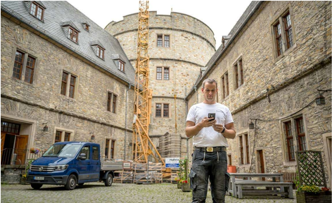
Dachdeckermeister Simon Pape loggt sich auf der Baustelle ein.
