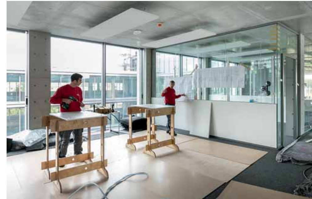
Die Montage der Trennwandsysteme erledigt der Tischler/Schreiner nach eigener Werkplanung.
