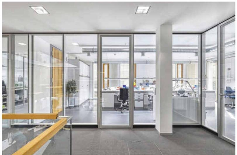
Zahntechnisches Meisterlabor mit Einblick: Glasflurwände mit Structural-Glazing-Doppelverglasung.
