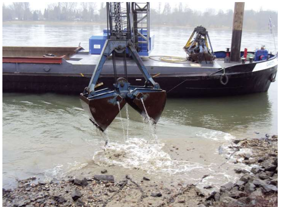
Baggerarbeiten am Rheinausslasskanal in Köln-Rodenkirchen
