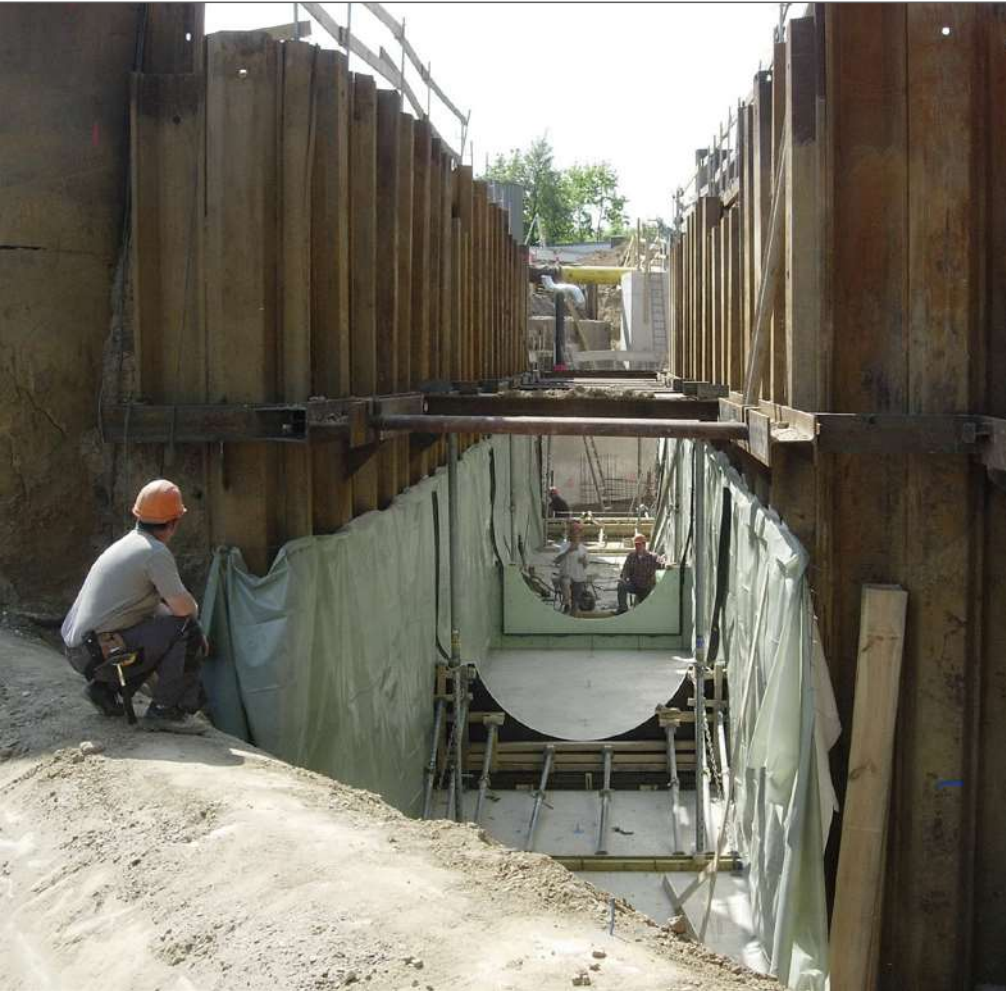
Das Ingenieurbüro Düplan bearbeitet u.a. Tiefbauprojekte. Im Bild: Zulauf des Transportsammlers in Köln-Porz.
