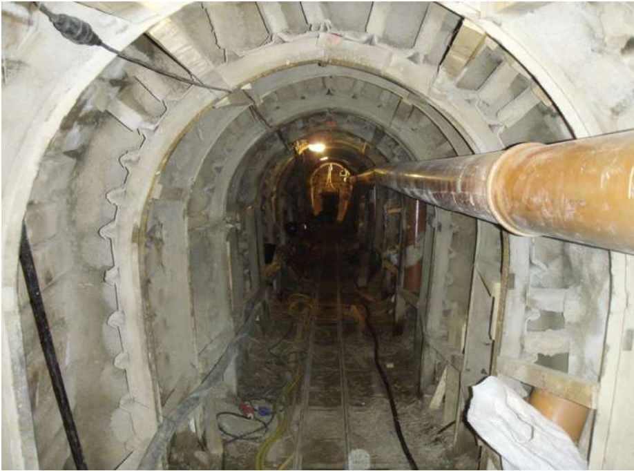
Spezialtiefbau im Stollen in Köln | Fotos: Düplan Planende Ingenieure, Zülpich
