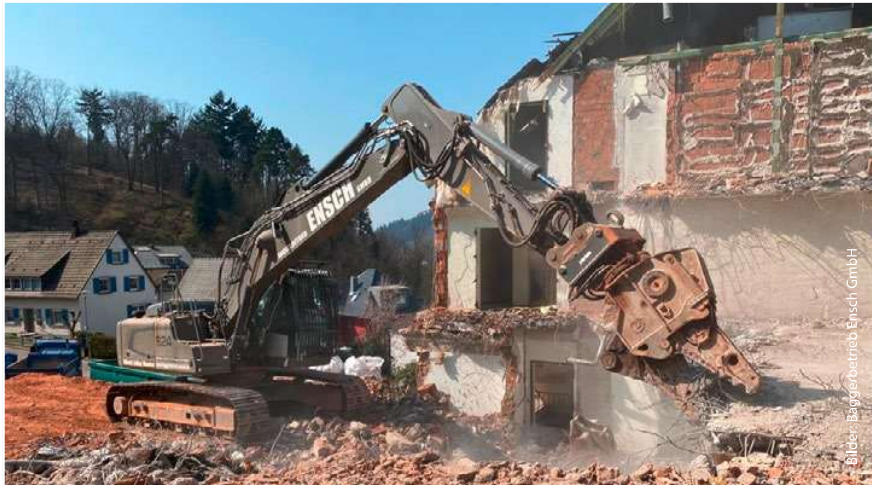
Bild oben: Teilabbruch eines Reihenhauses. Bild links: Herstellung eines Holzlagerplatzes für ein Sägewerk. Bild Mitte: Abbruch eines Hotels. Bild unten: Neubau eines Forstwegs.
