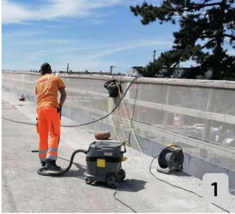
Bild 1: Reinigung nach HDW-Strahlarbeiten. Bild 2: Neuer Lagersockel in Achse vier mit Elastomerlager. Bild 3: Anschlussbewehrung mit Verbundankern für die neue Brückenkappe. Bild 4: Betonsanierung im Inneren der Hohlkästen. Bild 5: Aufbringen der Grundierung/Versiegelung mit PMMA-Harz.
